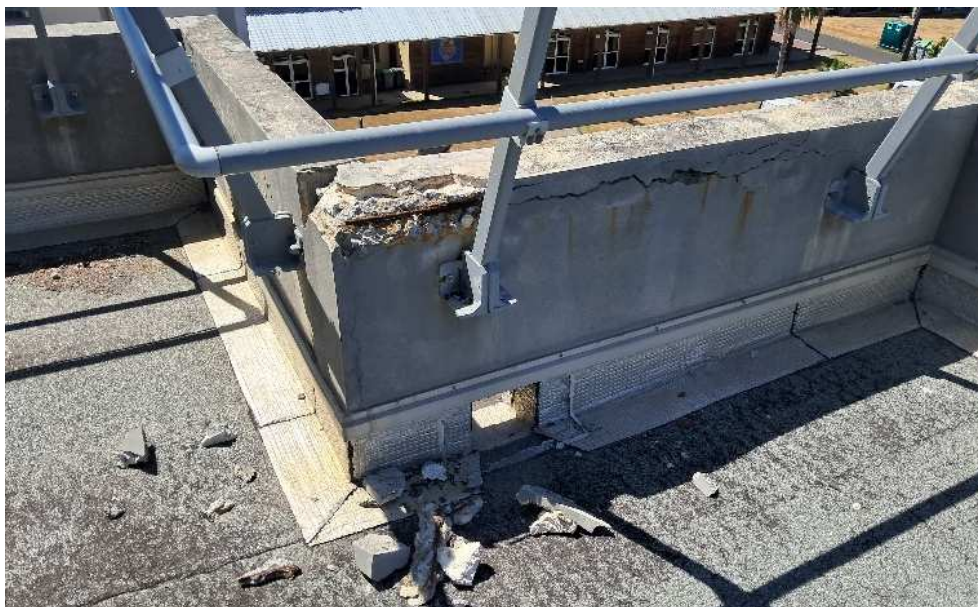
Figure 13 : Amorce de fissuration +et éclatement du béton avec aciers apparents oxydés sur l'acrotère
