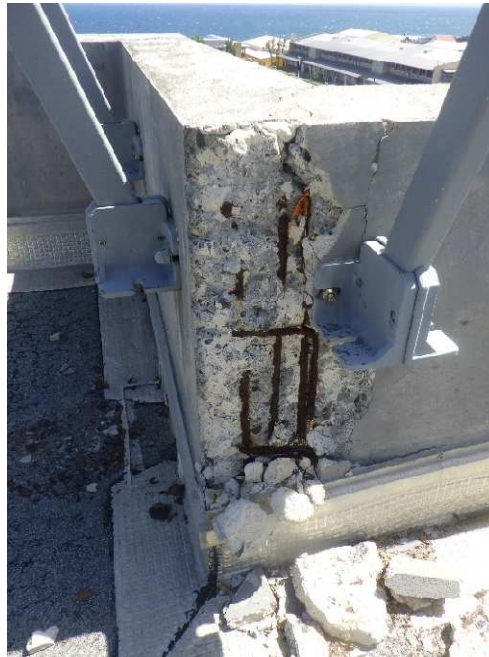
Figure 14 : Eclatement d'acrotère avec aciers apparents oxydés et sous-enrobage
